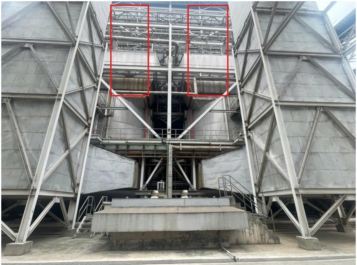
Hình 17: Vị trí dự kiến lắp SCR
